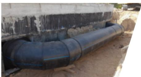
Isso tem que ser feito por camadas sucessivas de cerca de 10 cm até uma altura de 30 cm acima da geratriz superior dos tubos, atingindo 95% Próctor Normal na compactação. O processo de compactação deve ser realizado de forma equilibrada em ambos os lados do tubo para equilibrar a pressão sobre o mesmo.
